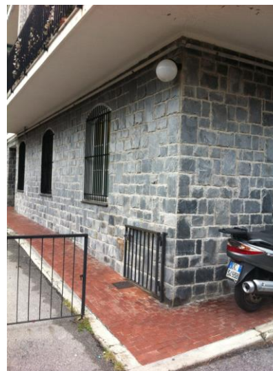
Figura 1.1 - Vista della facciata esposta a Sud-Est
