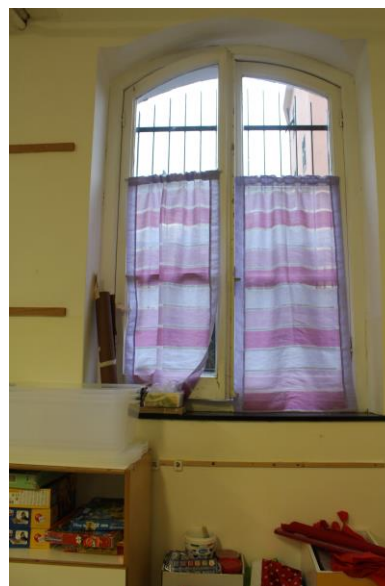
Figura 4.4 - Particolare dei serramenti in legno
